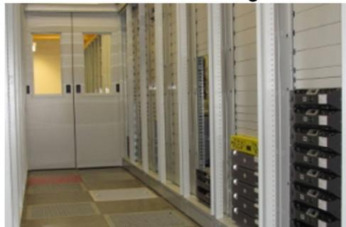
Zur Modernisierung und Leistungsanpassung der Klimatisierung im zentralen Serverraum des Universitätsrechenzentrums erfolgt über das Jahr 2014 hinweg die stufenweise Einführung von Kaltgang-Einhausungen für mehrere Serverstandorte. In diesem Zusammenhang begann am 4. Februar 2014 ein erster, dreiwöchiger, zentraler Bauabschnitt. Umfangreiche Vorkehrungen wurden getroffen, um einen reibungslosen und unterbrechungsfreien Betrieb der IT-Dienste am Campus der TU Chemnitz sicherzustellen.
