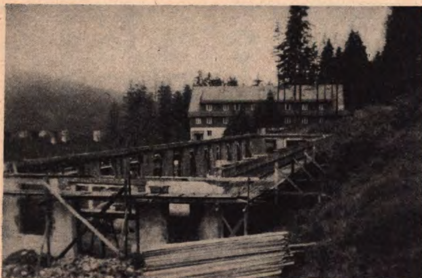
Maschinenlabor im Bau
