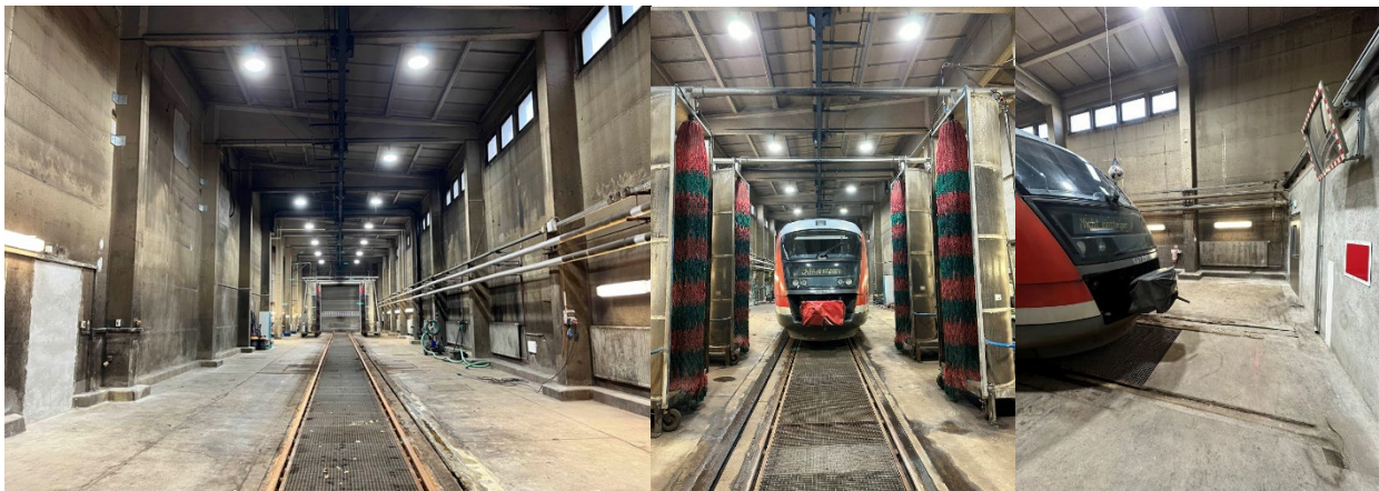
Abbildung 6: Waschhalle mit dem SIEMENS Desiro BR 642
