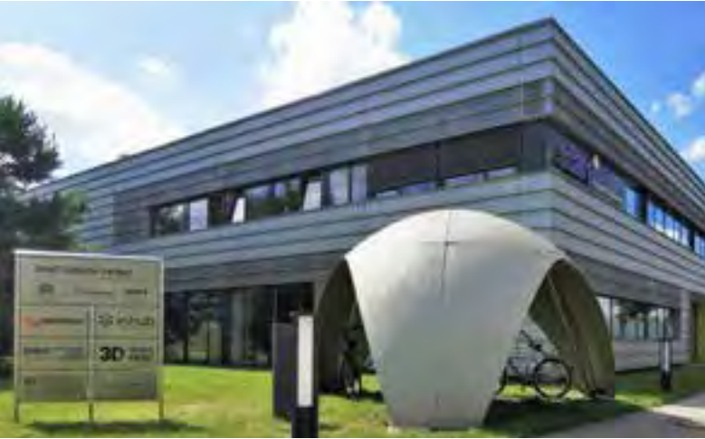
Start-up Gebäude am Technologie-Campus
