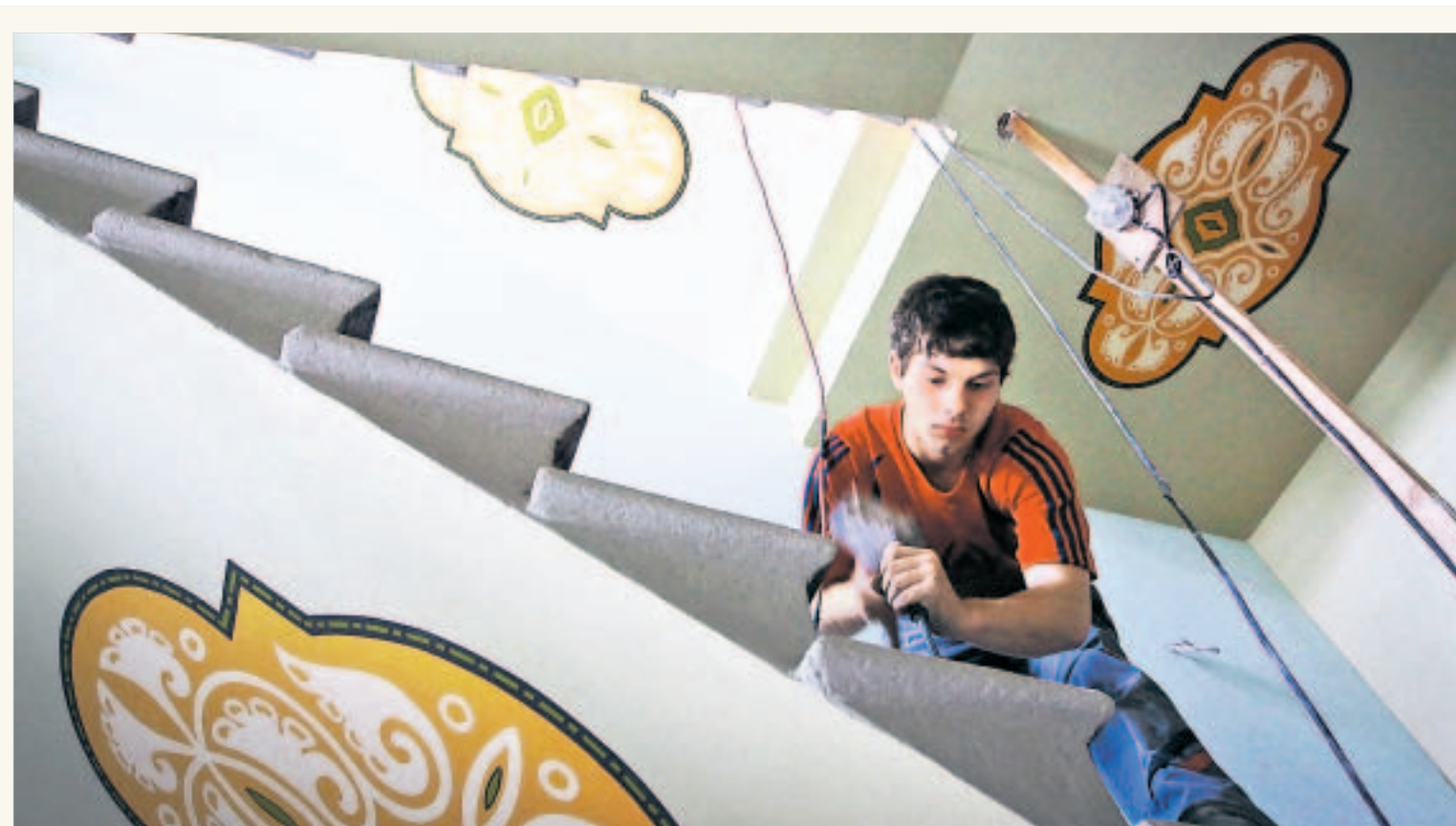
Patrick Scholz, Auszubildender bei der Tischlerei Scheibe & Sohn aus Zodel, arbeitet im Treppenhaus des Gebäudes Otto-Buchwitz-Platz 3. Hier fehlt derzeit noch das hölzerne Geländer. Die Malereien sind nach historischen Befunden aufgearbeitet worden. Fotos: Nikolai Schmidt
