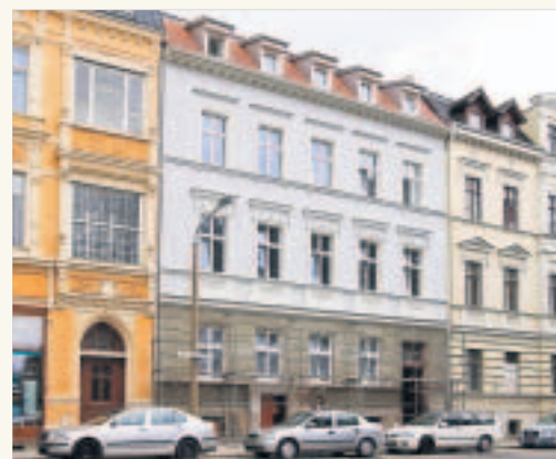
Das Haus Otto-Buchwitz-Platz 3 ist mittlerweile auch von außen fast fertig saniert.
