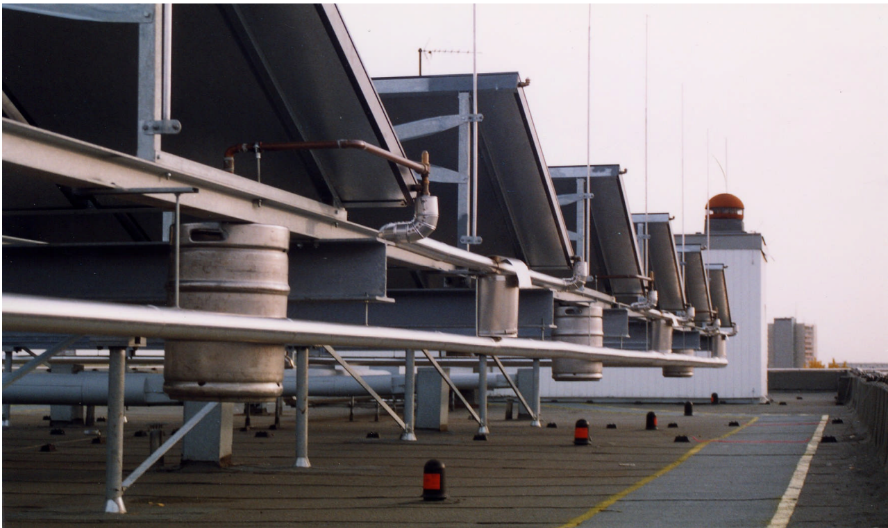
Abb. 6.7: Flachdachaufständerkonstruktion mit punktuell abgestützter Stahlbaukonstruktion (B-Lichttg.)
