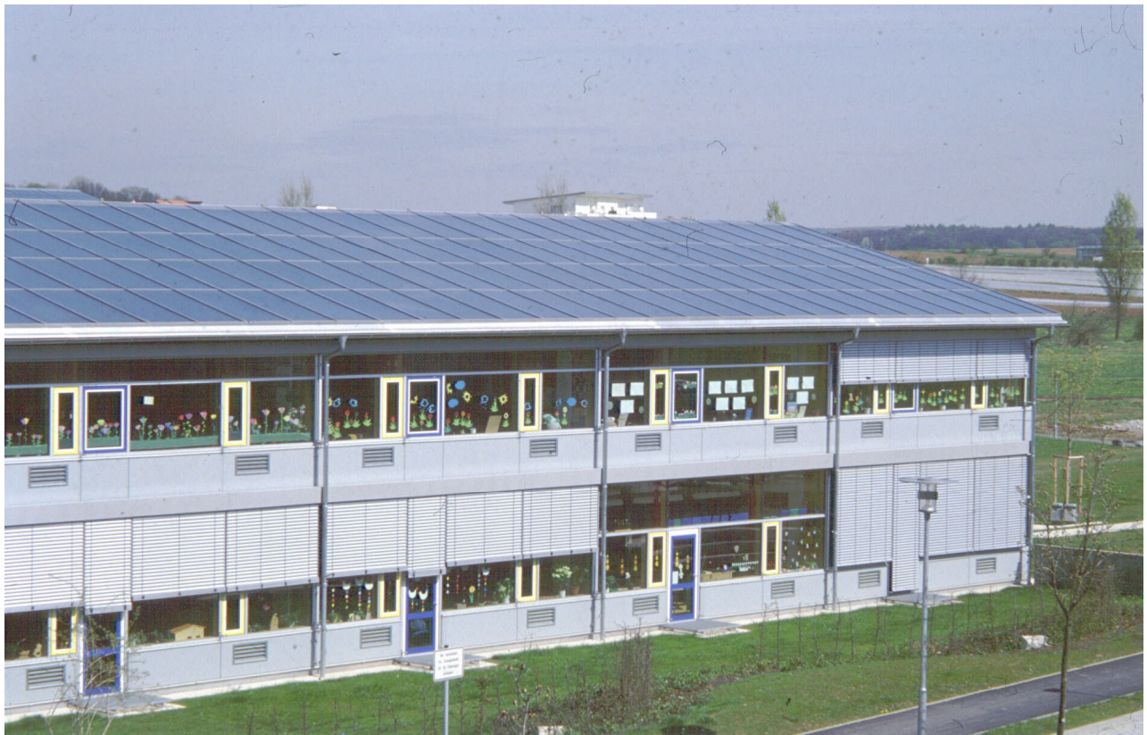
Abb. 6.4: Solar-Roof im Projekt Neckarsulm-Amorbach (Bild: Dirk Mangold, ITW, Universität Stuttgart)
