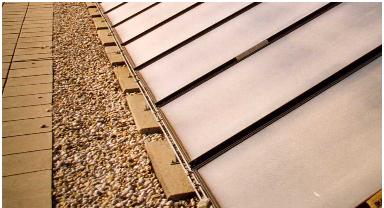
Abb. 6.6: Flachdachaufständigung mit dachaufliegenden Betonplatten (M-Baumgartnerstr.)
