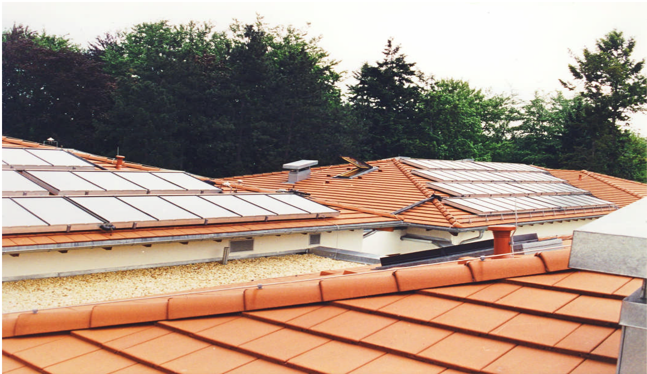
Abb. 6.3: Aufdachmontage eines Kollektorfeldes (Anlage Pößneck)
