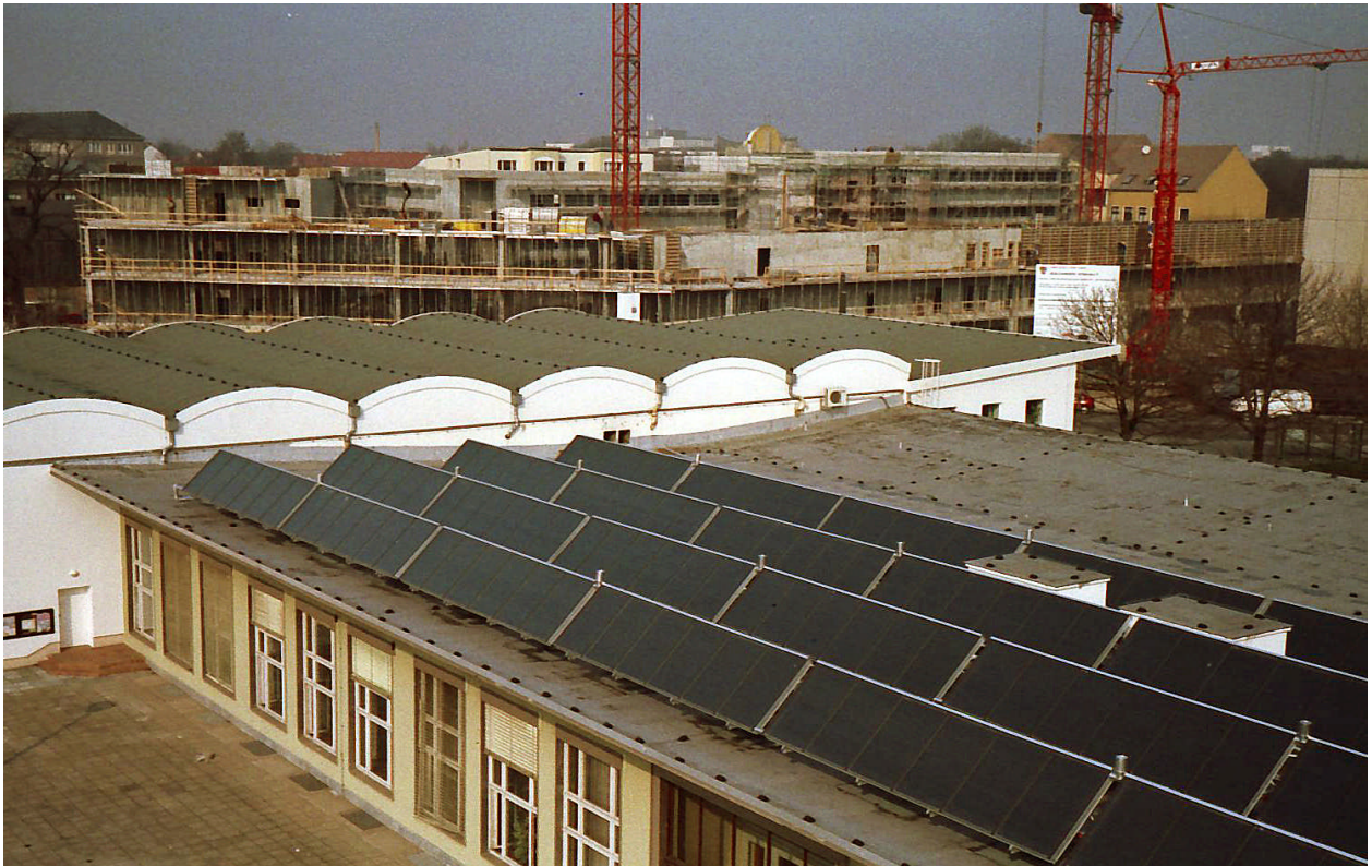
Abb. 10.5: Teilansicht des Kollektorfeldes auf der Mensa (Studentenwohnheim Uni Magdeburg)
