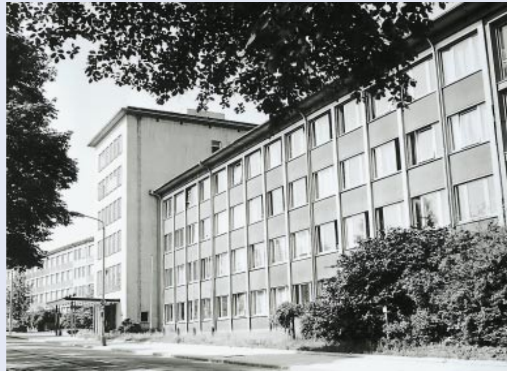
Universitätsgebäude an der Reichenhainer Straße (um 1960)
