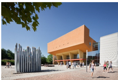
TU Chemnitz, Zentrales Hörsaal- und Seminargebäude (©www.chemnitz.de)
