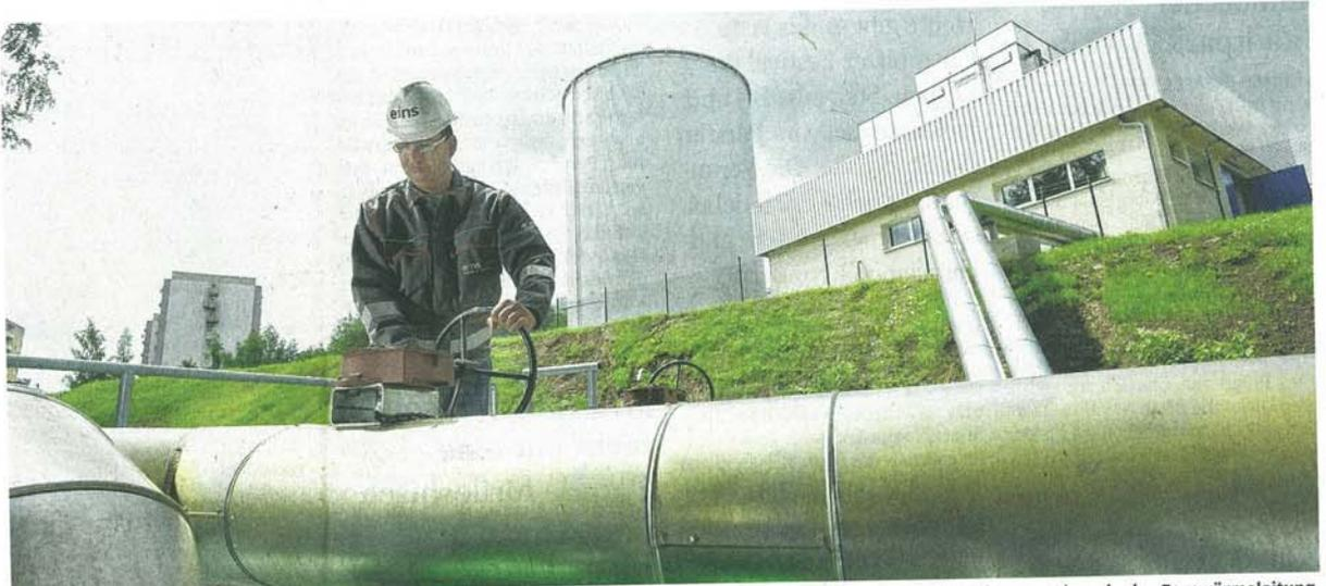
Am Rande des Küchwalds wird aus Wärme kaltes Wasser: Tino Weber, Servicemonteur des Chemnitzer Versorgers Eins, am Abzweig der Fernwärmeleitung, die die neue Kälteversorgungsanlage des Klinikums Chemnitz (im Hintergrund der 16 Meter hohe Kältespeicher) mit Energie versorgt. FOTO: ANDREAS SEIDEL
