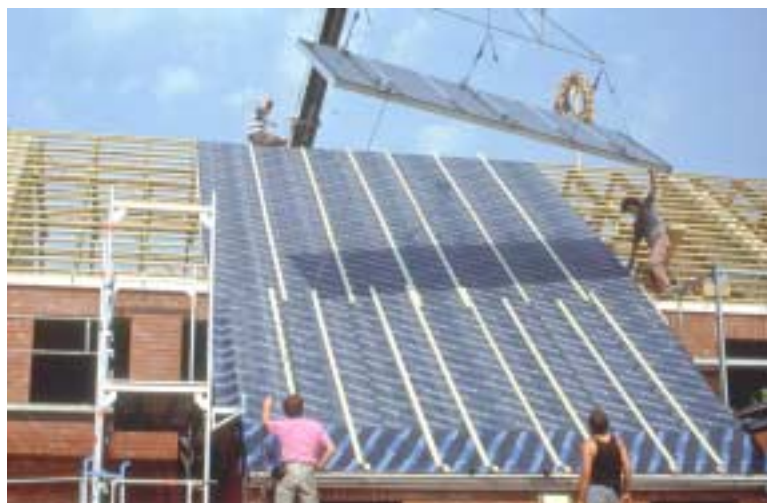
Bild 8: Montage von großen Kollektorflächen in Hamburg
