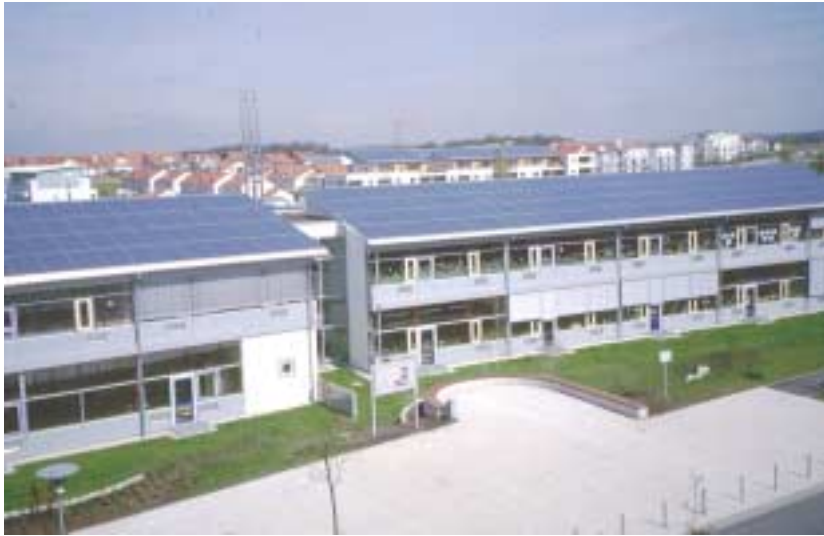
Bild 11: Kollektordach auf der Grundschule in Neckarsulm-Amorbach
