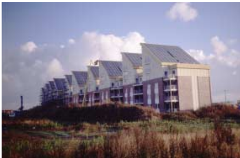
Bild 1: Pilotanlage in Rostock-Brinckmanshöhe
