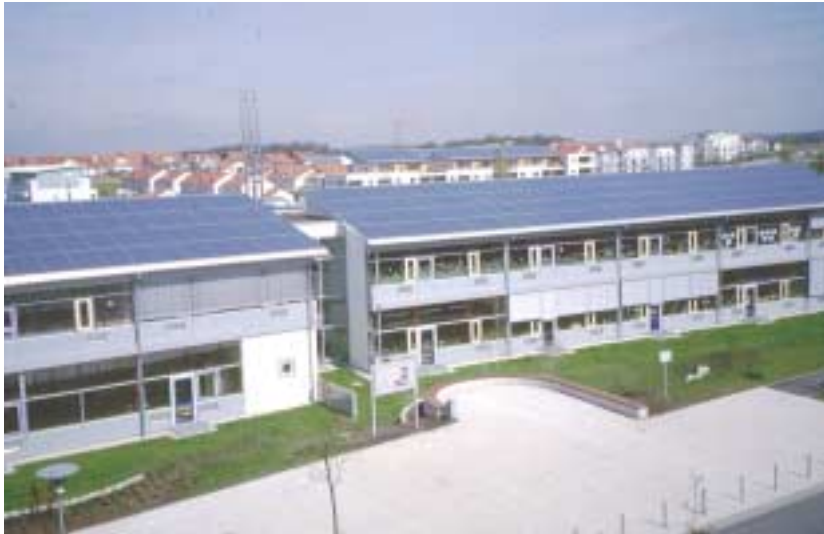
Bild 11: Kollektordach auf der Grundschule in Neckarsulm-Amorbach
